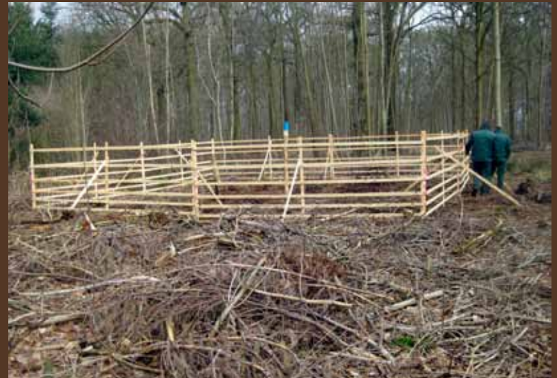
Figuur 3: Houten hek per kloemp, elk paneel wordt verstevigd met een dwarslat
