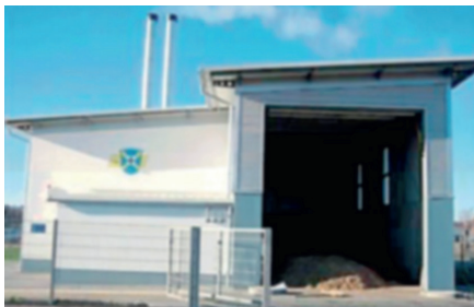
Bovengrondse, gelijkvloerse, overdekte silo voor houtsnippers
